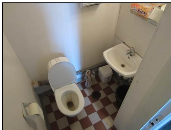
Kuva 38. Yleiskuva alkuperäisestä wc-tilasta.
