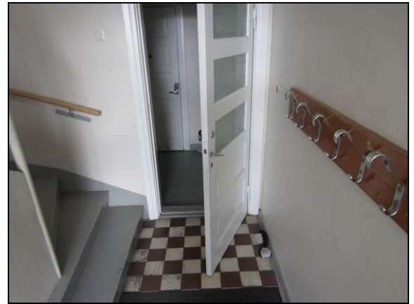
Kuva 32. Rakennuksen keskiosan porrashuone.
