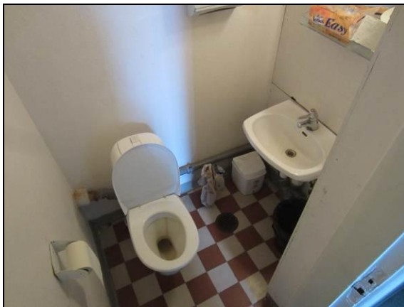
Kuva 41. Vesikalusteita on osin uusittu.
