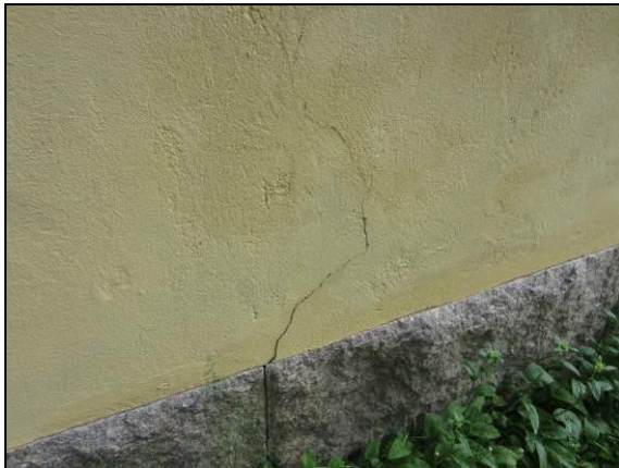
Kuva 11. Halkeama julkisivussa.
