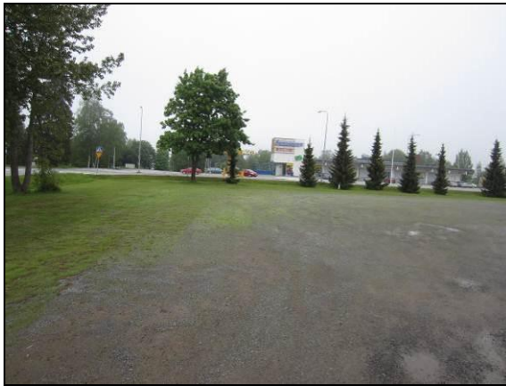
Kuva 3. Nurmi on levinnyt päällysrakenteiden puolelle.
