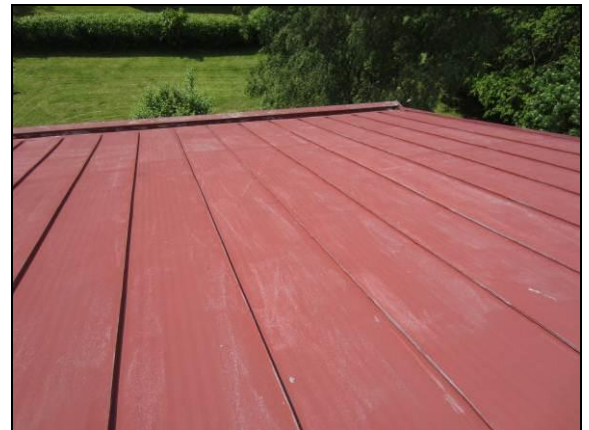
Kuva 26. Katteen pinnoite on haalistunut.
